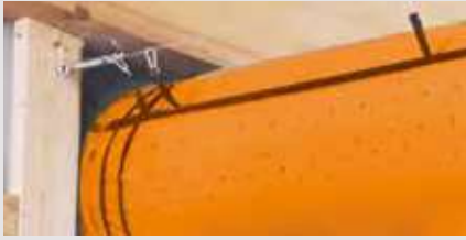
Der Tube wird mithilfe von Spannbändern an den Ventilator angeschlossen und mit Spannvorrichtungen an einem Edelstahlseil befestigt.
