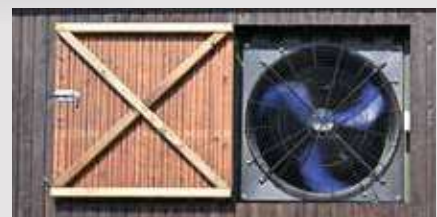
Der Ventilator wird, wenn möglich, in die Außenwand des Stalls eingebaut oder durch einen angrenzenden Raum mit ausreichend Luftvolumen mit der Außenwelt verbunden. Dieser ist mit dem Tube verbunden und versorgt den Stall mit Frischluft. 24 Stunden am Tag, an 365 Tagen im Jahr.
